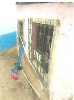
FOTO 4.: SUSTITUCIÓN DE VENTANAS Y BARANDAS. Sustitución de ventanas en mal estado y baranda en mal estado por baranda internas en el vano.
