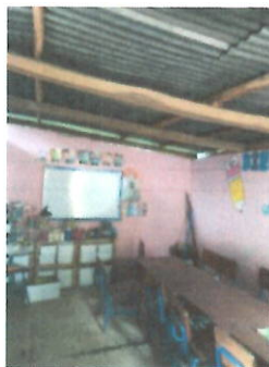
FOTO 1.: ESTRUCTURA DE TECHO. Sustitución de estructura de techo en mal estado.
