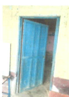
FOTO 6.: PUERTA. Sustitución de puerta en mal estado por puerta de metal con chapa bisagra y marco,
